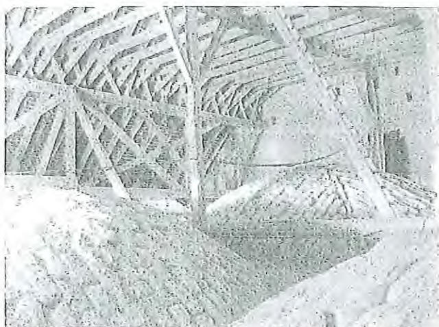
Extrados des voûtes centrales du chœur.
